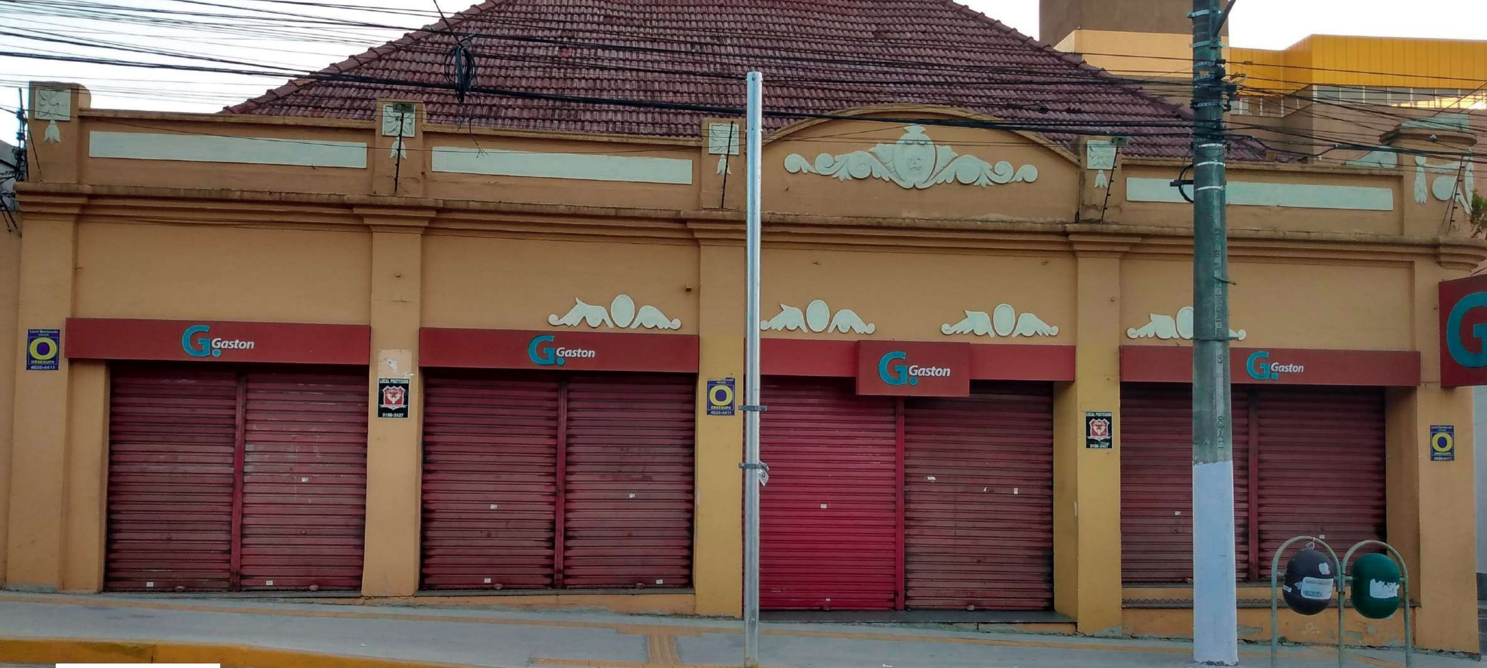
vista frontal do prédio pela Av. José Loureiro da Silva (2021)
