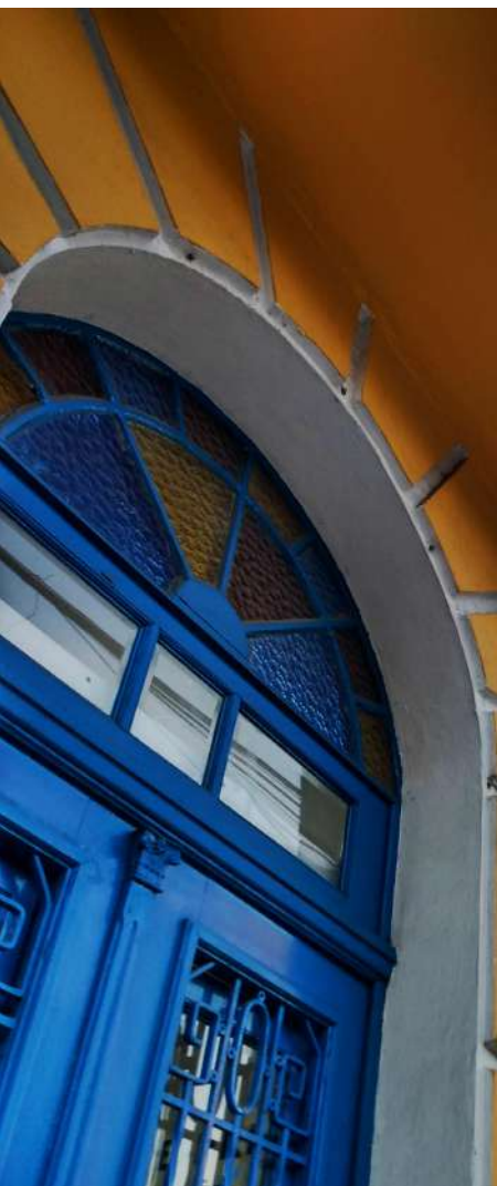
detalhe das portas com bandeiras (2021)
